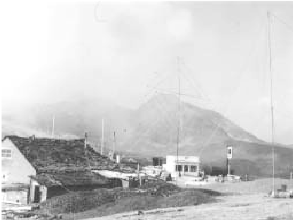
August 1968, PX1UP auf dem Passo di Envalira 2407 m.ü M, Ausrüstung Motosacchoche Generator 1.2 kW, SWAN TRX, RX RME6900, TX FL100, Linear FL1000, W3DZZ und Koni's geniale Faltquad (System Regenschirm) im Bild links die Unterkunft mit Geissengeruch der uns aber nicht störte, das Feeling des Pileups nach PX1UP war grösser wir haben in 5 Tagen ~4600 QSO's gemacht, das Wetter war im August nass, kalt und stürmisch wir haben manchmal um unsere Antennen gezittert, aber immer noch in guter Erinnerung. HB9ATX
