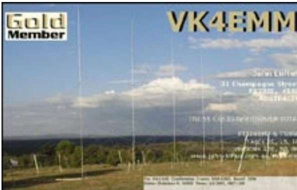
Die Antennenanlage, 40 m Vertikal-beam von John, VK4EMM
